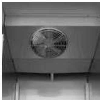
Крышка испарителя из нержавеющей стали
